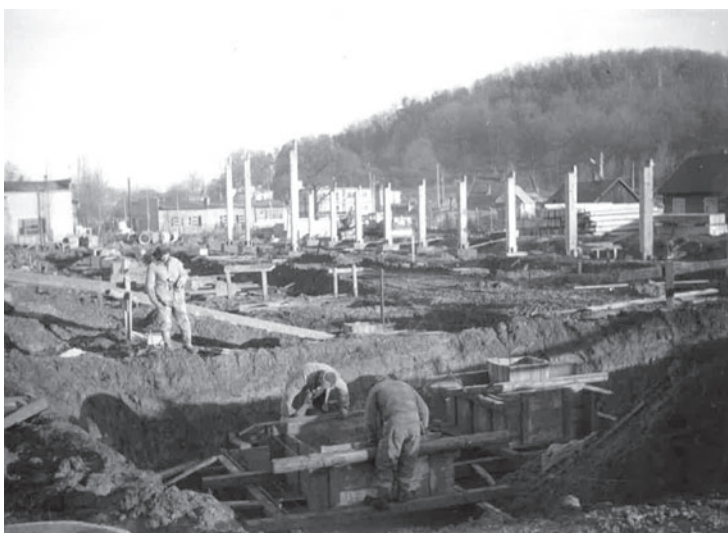
Budowa hali głównej, 1962.
